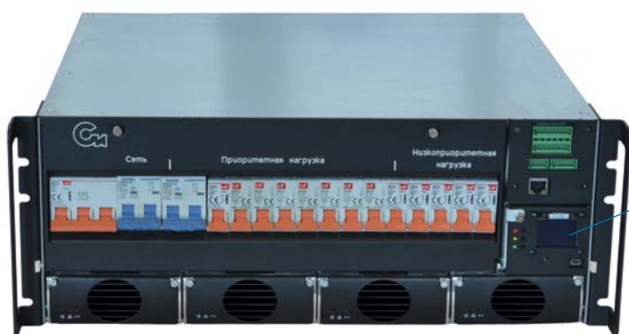
УВС48-12 с установленными 4 выпрямителями 3 кВт
